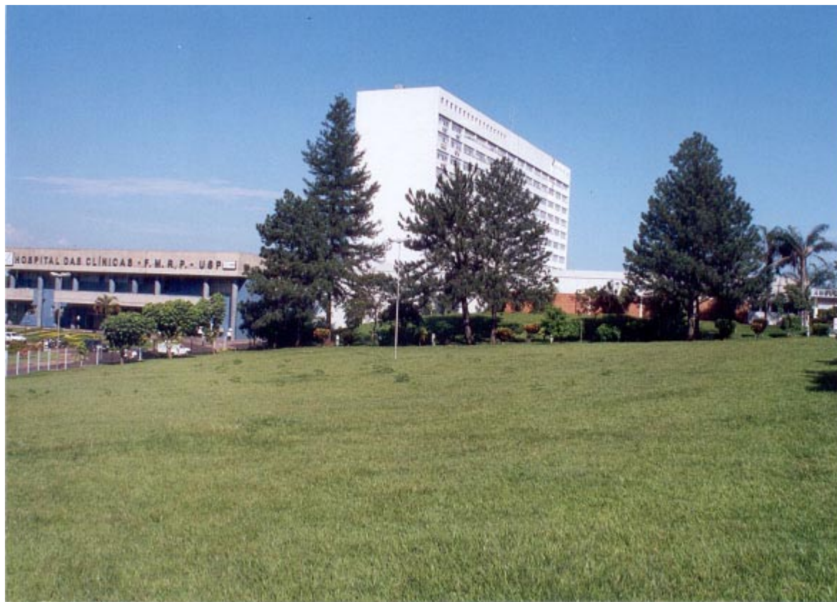
Foto 5 – Hospital das Clínicas da FMRP-USP – Campus da USP.
