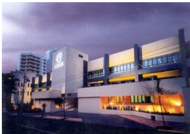
Foto 7 - Centro de Convenções Ribeirão Preto da Fundação de Apoio ao Ensino, Pesquisa e Assistência do HCFMRP-USP (FAEPA), à Rua Bernardino de Campos, 999.
