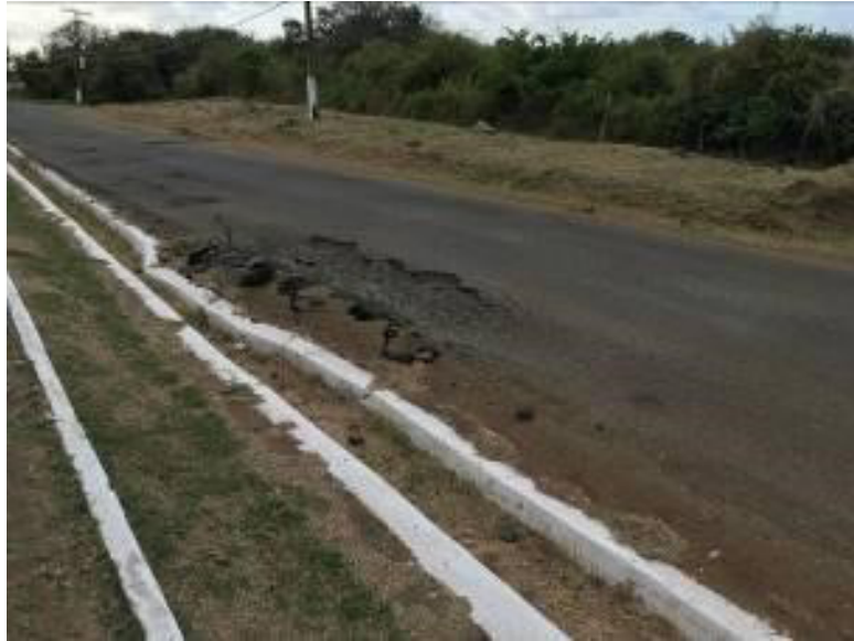
Figura 6 - Via pavimentada no acesso ao Forte do Boldró
